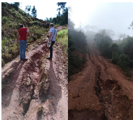
Figura 44: Registro de erosão na BHCUIJ
